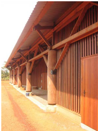
Porte en Moabi, poteaux en Tali, charpente en Kosipo, bardage à claire-voie en Mukulungu - Réalisation J.Y. Riaux - Mindourou (Cameroun)
